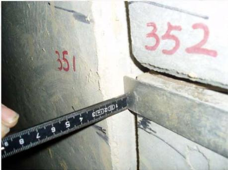
Versatz in einer Tübbingfuge bedingt durch fehlerhafter Ringspaltverpressung
